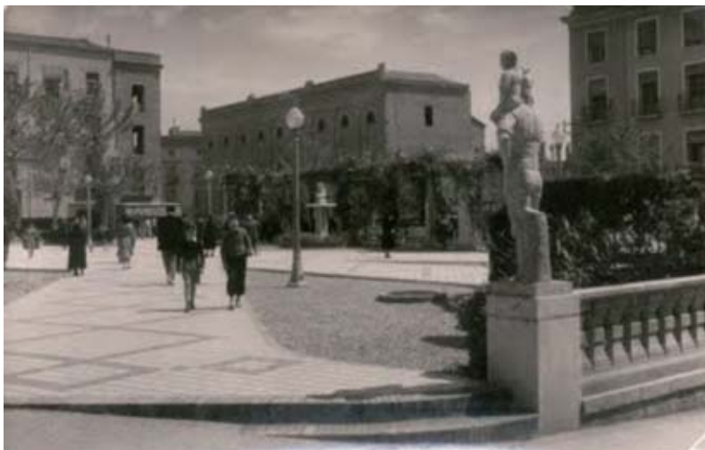
Antiguo convento de las Mínimas de Valls
